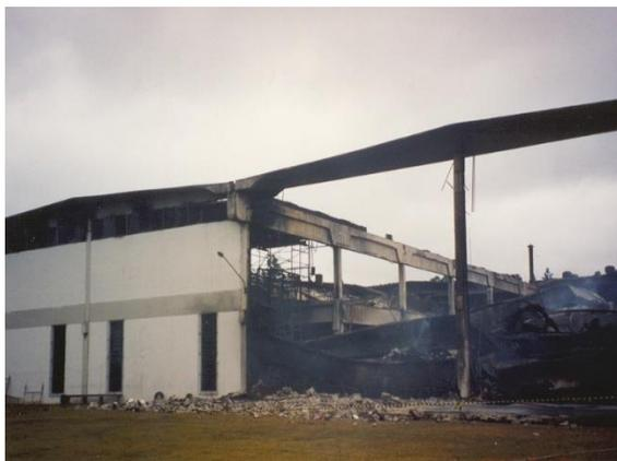
Figura 11. Ruína de edifício com estrutura pré-moldada submetida a incêndio
