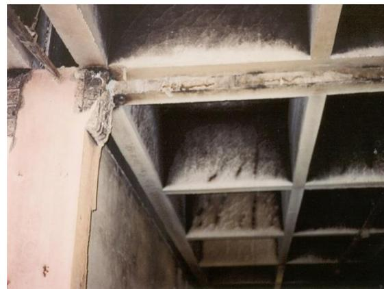
Figura 12. Deslocamento de apoio de estrutura pré-moldada submetida a incêndio
