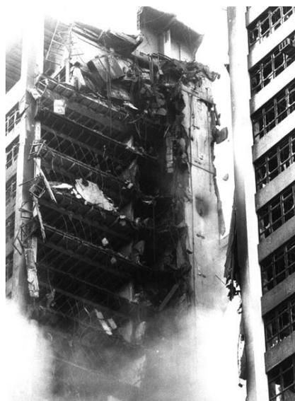
Figura 14. Detalhe da ruína da estrutura de concreto do edifício Sede II, mostrando as duas partes remanescentes da torre.
