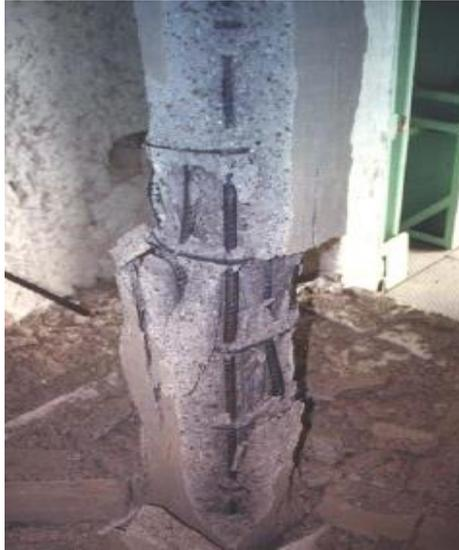
Figura 10. Exemplo de *spalling* explosivo ocorrido em pilar de concreto de alta resistência  $f_{ck} = 83$  MPa (Kodur et al., 2005).
