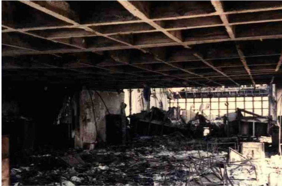
Figura 15. Vista da parte frontal da estrutura do edifício Sede II, a partir de sua parte posterior, com destaque para o vazio, deixado pelo desabamento da parte central
