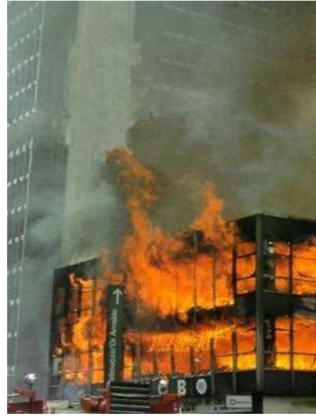
Figura 2 - Podio del edificio Grande Avenida, sometido a fuego en 14/02/1981
