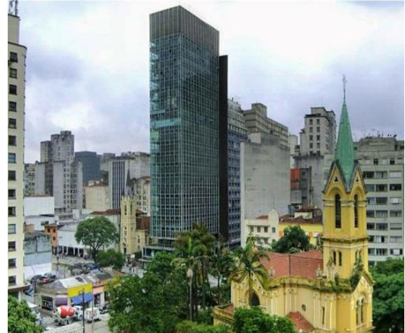
Figura 4 - Edificio Wilton Paes de Almeida, situado en el centro de Sao Paulo
