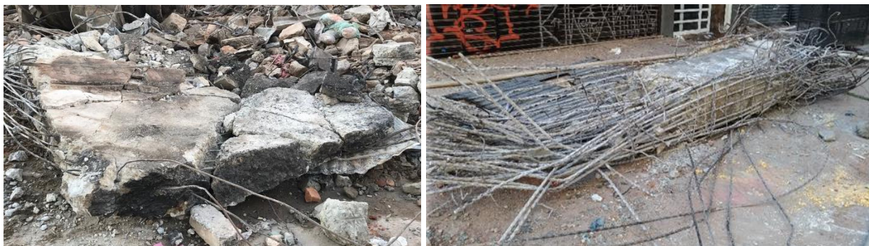
Figura 10. Secciones de losa en voladizo y columnas/pilares recogidos de los escombros para los ensayos (fuente: colección personal de Paulo Helene)
