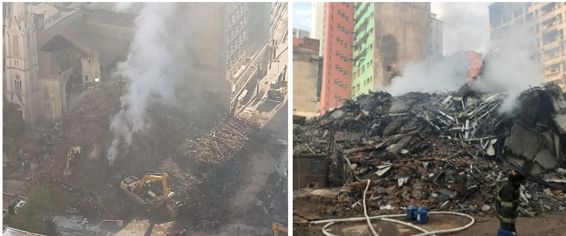
Figura 2. Edificio Wilton Paes de Almeida después de su colapso (fuente: colección personal de Paulo Helene).
