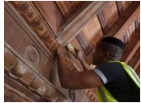
Figura 7. Medição da umidade superficial dos elementos.
