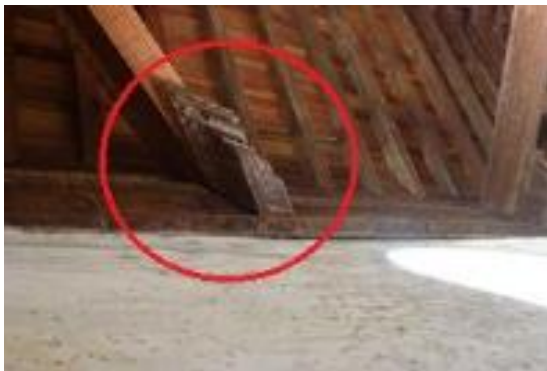
Figura 18 e Figura 19. Deslocamento de apoios enviesados (Ce7 e Ce8) sob o quadrado 4 (Cd4).
