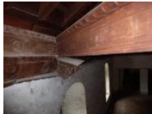
Figura 18 e Figura 19. Deslocamento de apoios enviesados (Ce7 e Ce8) sob o quadrado 4 (Cd4).
