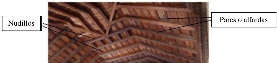
Figura 2. Elementos estructurales de la armadura del Coro alto del convento.
