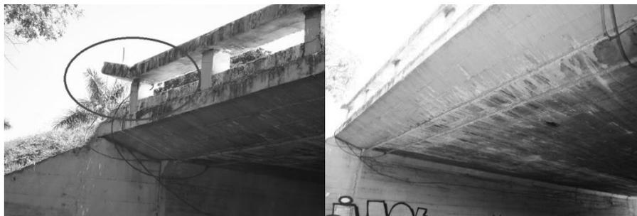
Figura 9. Daño en la estructura de la baranda de protección y vista general - daño en la losa por recorrido de vehículos debido la altura.
