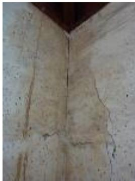
Figura 14. Grieta de 2 cm de ancho en intersección de ejes A-1.
