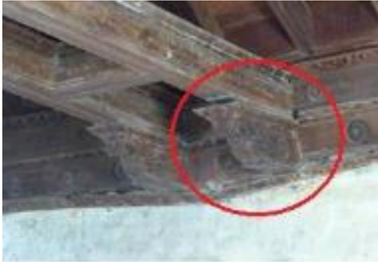
Figura 16. Descenso de can bajo el tirante 2 (T2), en eje 2.
