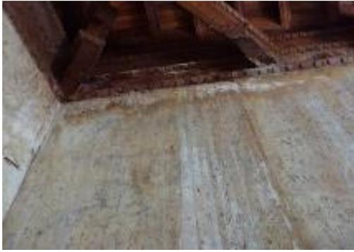
Figura 9. Muro en eje A con escorrentía.
