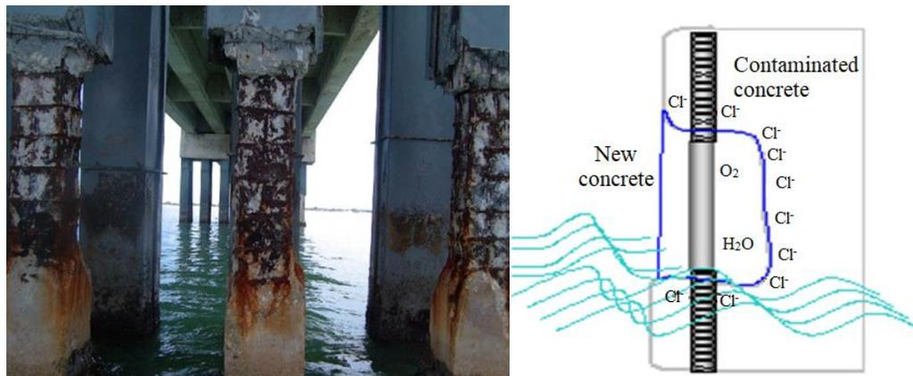
Figura 1. Propuesta de reparación de estructuras de concreto reparadas usando acero inoxidable Pérez Quiroz, (2009).
