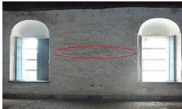
Figura 15. Grietas horizontales en la parte baja de muro (eje 1).
