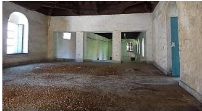
Figura 13. Suciedad en los muros producto de los excrementos de murciélagos y en el local producto de restos de sus alimentos.
