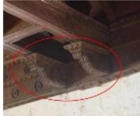
Figura 17. Descenso de canes bajo tirante 1 y 2 (T1 y T2), en eje 1.
