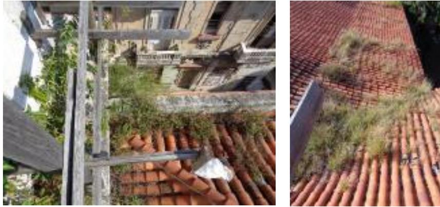
Figura 26 y Figura 27. Plantas invasoras en la cubierta del Coro alto.
