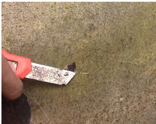
Figura 15. Dano mecânico em pintura de campo (Ribeiro Filho, 2018)
