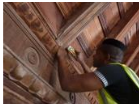
Figura 7. Medição da umidade superficial dos elementos.
