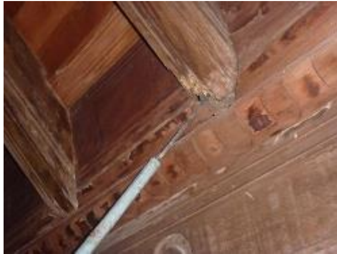
Figura 24. Sondagem de elementos de madeira com punção graduada.
