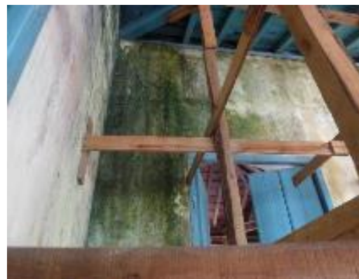
Figura 7 e Figura 8. Fungos na parede da galeria no eixo 2 do Coro.
