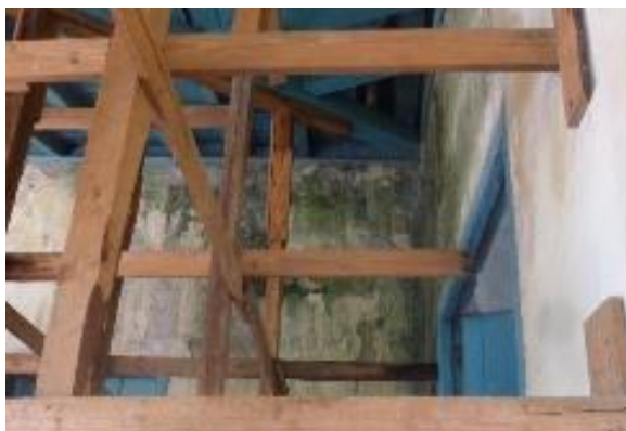
Figura 7 e Figura 8. Fungos na parede da galeria no eixo 2 do Coro.
