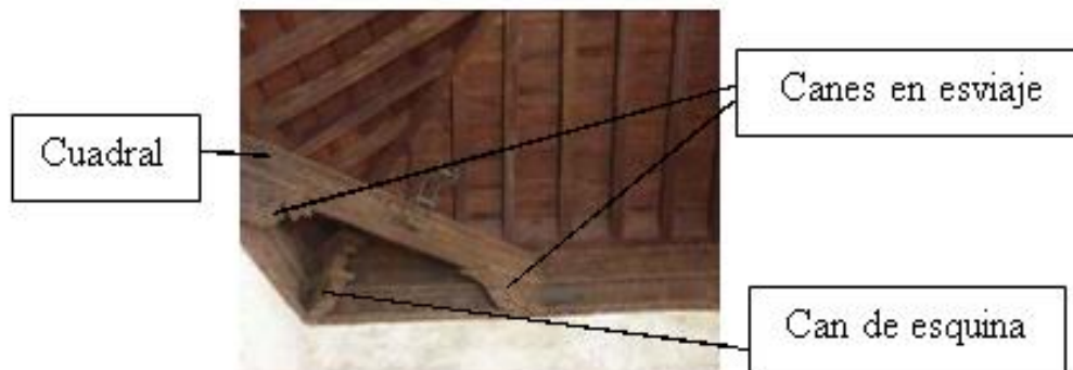
Figura 4. Cuadral, apoio transversal e apoio de canto.
