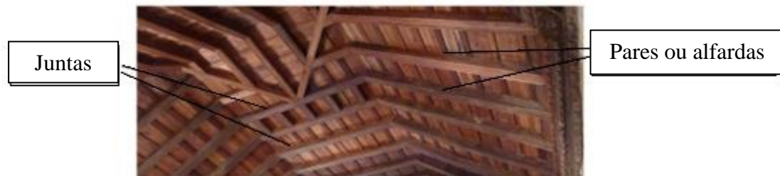
Figura 2. Elementos estruturais da treliça do coro alto do convento.
