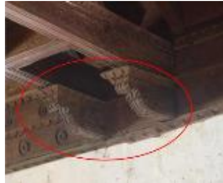
Figura 17. . Deslocamento de apoios sob os tirantes 1 e 2 (T1 e T2), no eixo 1.
