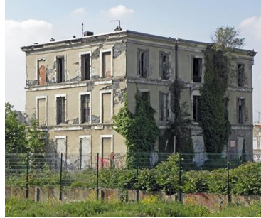
Figura 3. Coignet House a las afueras de Paris, Francia (4 pisos). Considerada la primera casa en concreto armado del mundo, 1853. Mortero o concreto primitivo con arcilla calcinada mezclada con cal.
