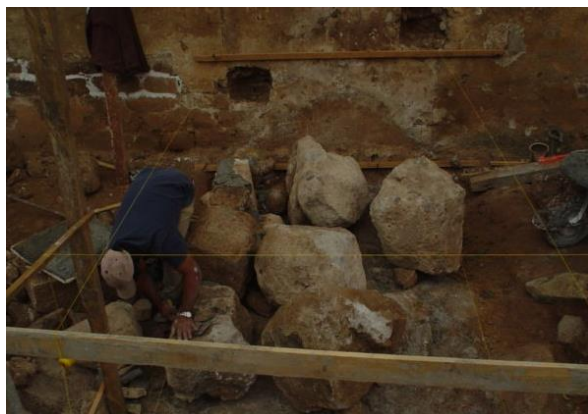
Figura 12. Cimentación de contrafuerte.
