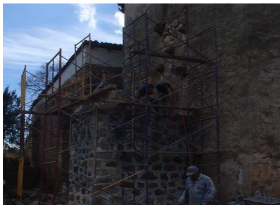
13. Proceso de restauración de los contrafuertes
