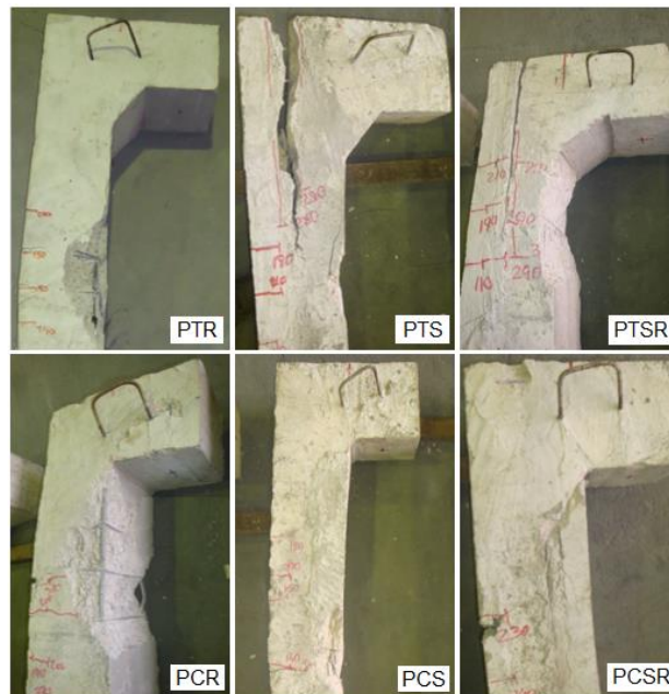
Figura 11. Detalle de las columnas luego de la ruptura.
