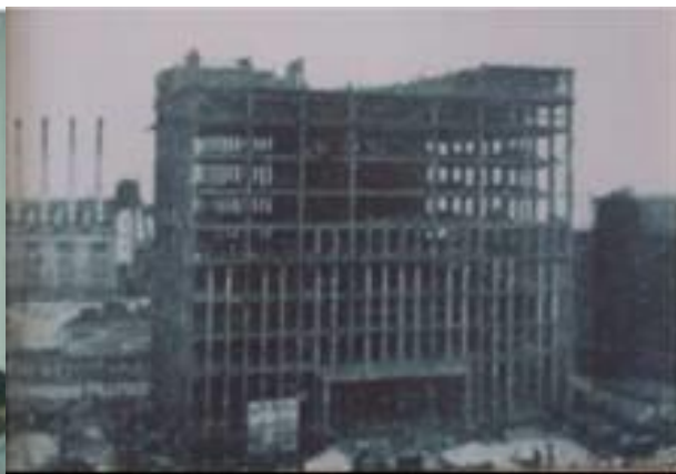
Foto da construção
