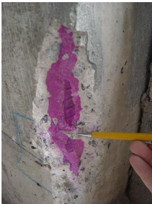
Figura 6. Ensaio de profundidade de carbonatação em pilares de concreto armado.
