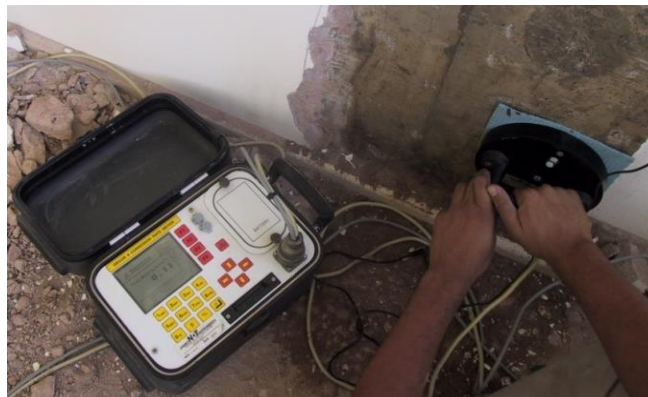
Figura 8. Leitura da velocidade de corrosão com o GECOR.
