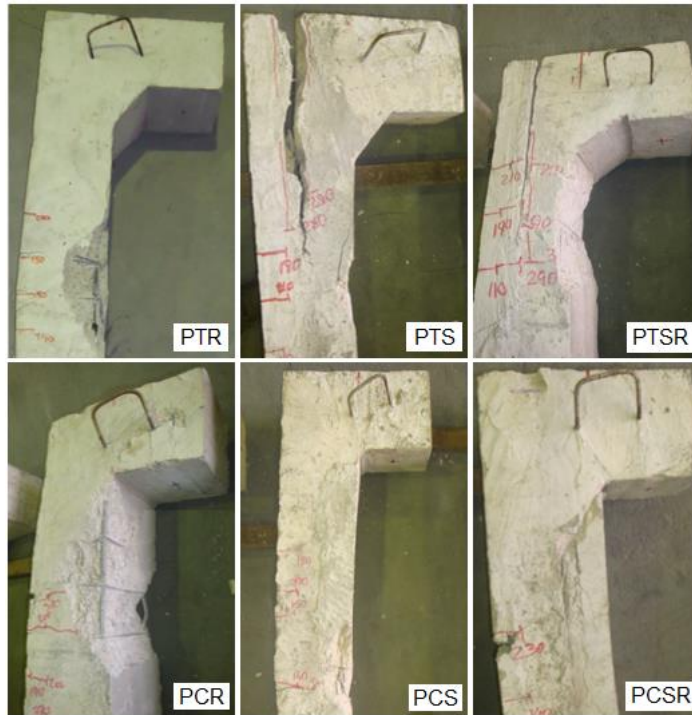
Figura 11. Detalhe dos pilares após a ruptura.
