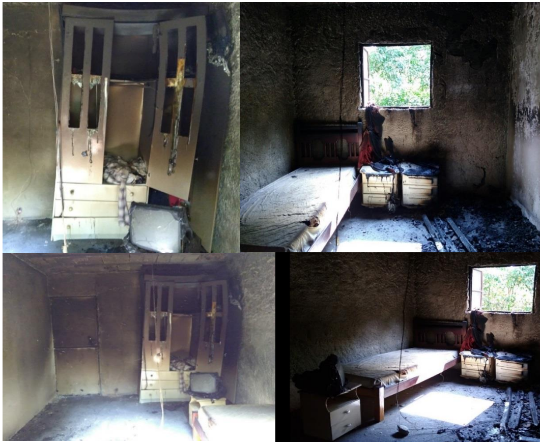
Figura 12. Imágenes del cómodo después del incendio.
