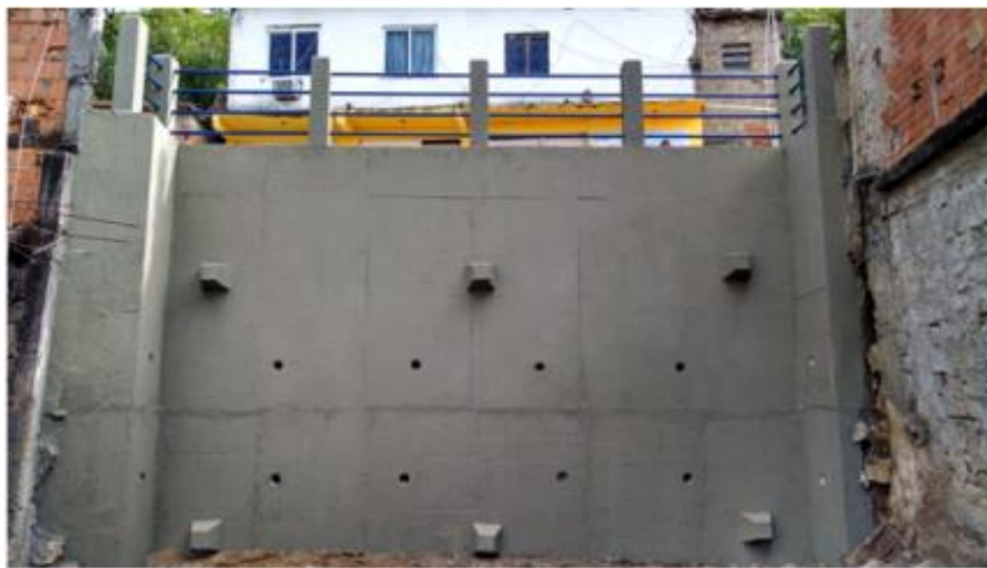
Figura 2. Vista de una cortina anclada en área de riesgo geotécnico: (Autor)
