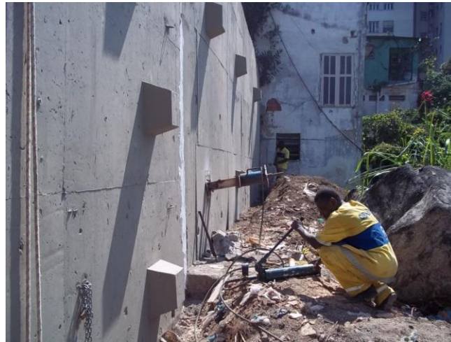
Figura 7. Ensayo de verificación residual de carga en andamento.
