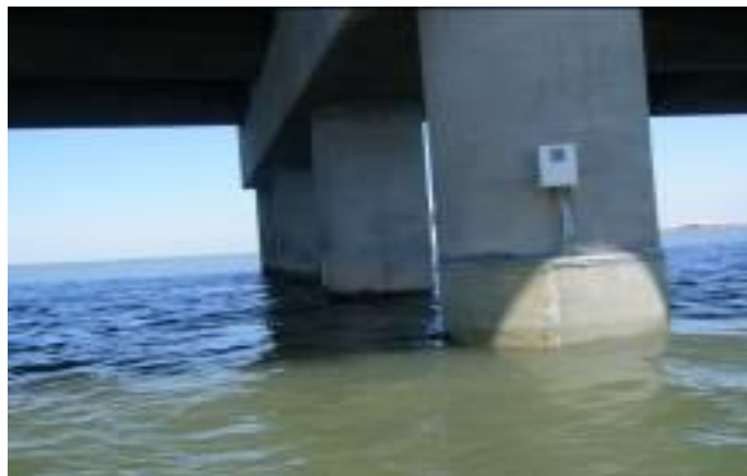
Figura 5. Protecção com fibra de vidro de pilares
