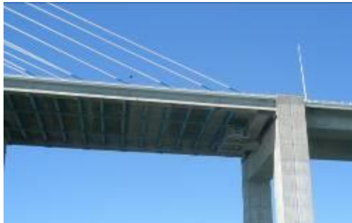
Figura 4. Veículo de inspecção da ponte
