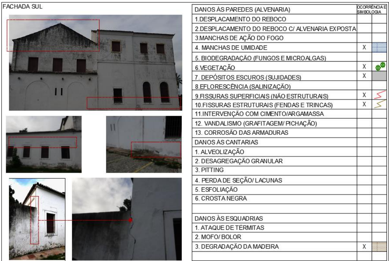
Figura 8. Ficha de Identificação de Danos da Fachada Sul da Igreja do Carmo. Fonte: Autores.
