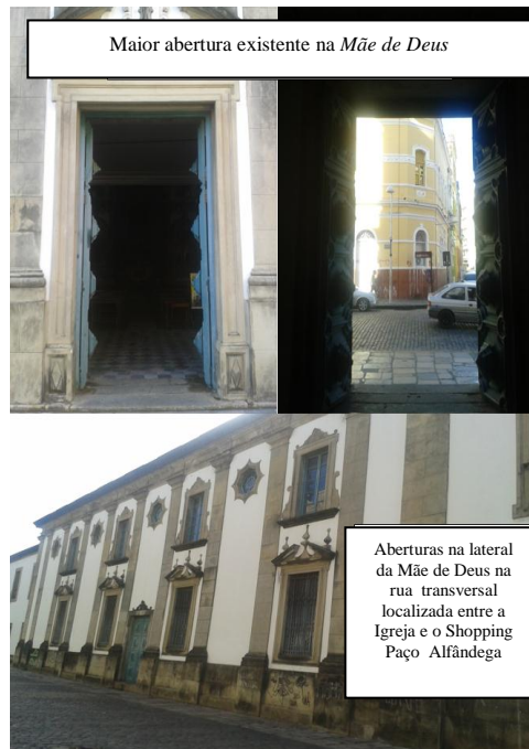
Figura 2. Aberturas para ventilação e exaustão de fumaça da Igreja Mãe de Deus.
