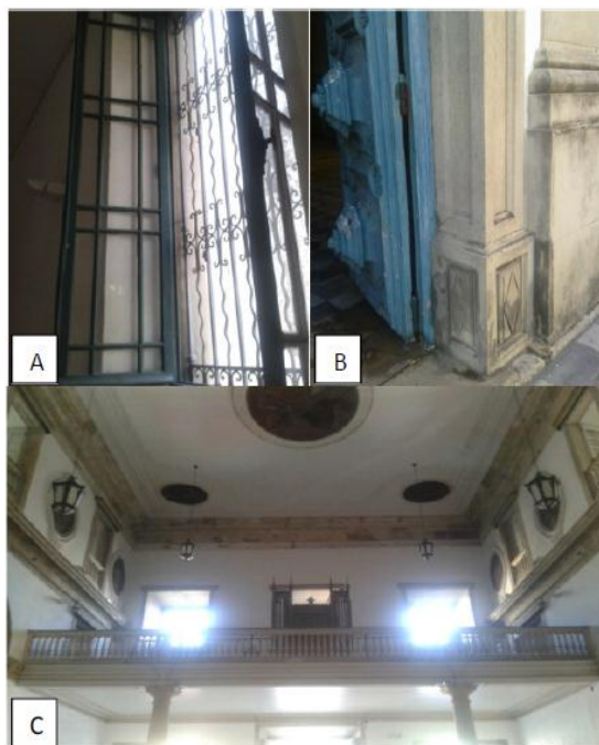
Figura 3. Ausência de compartimentação vertical no interior da Igreja Mãe de Deus. A – Varanda e janelas dentro da igreja; B – Escadaria tipo comum; C – Varanda dentro do próprio edifício.
