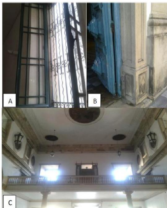
Figura 3. Ausencia de compartimentación vertical en el interior de la Iglesia de la Madre de Dios. A – Balcón y ventanas en el interior de la iglesia; B – Escalera del tipo común; C – Balcón dentro de la propia edificación.
