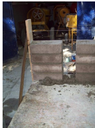
b) Guias para as juntas da argamassa
