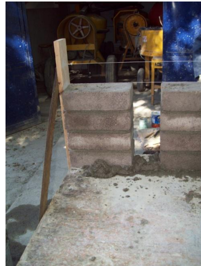
b) Guías para juntas de mortero
