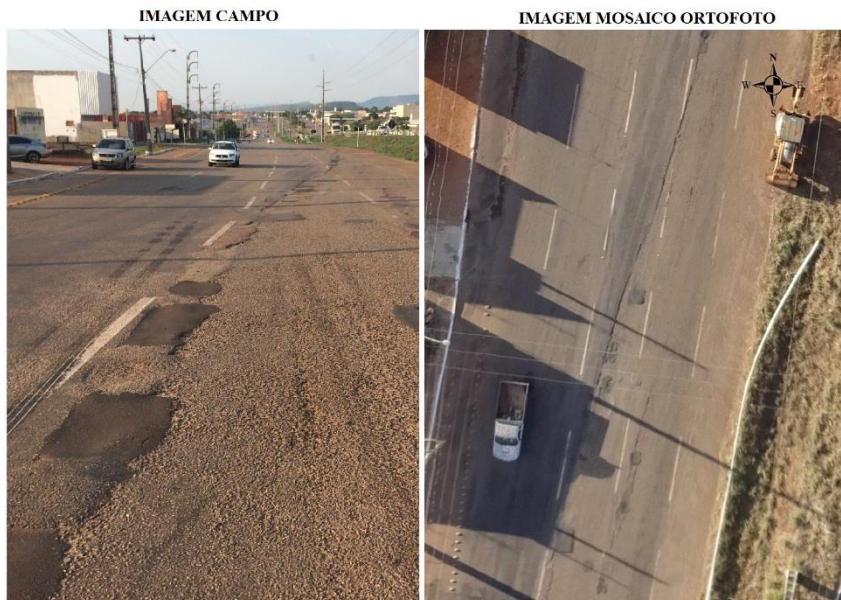
Figura 7. Junta de servicio en trecho ampliado da vía.
