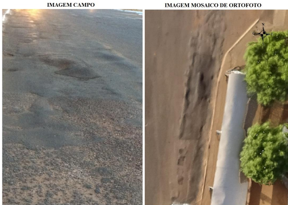
Figure 6. Hundimientos y levantamientos en el trecho de tráfico pesado.
