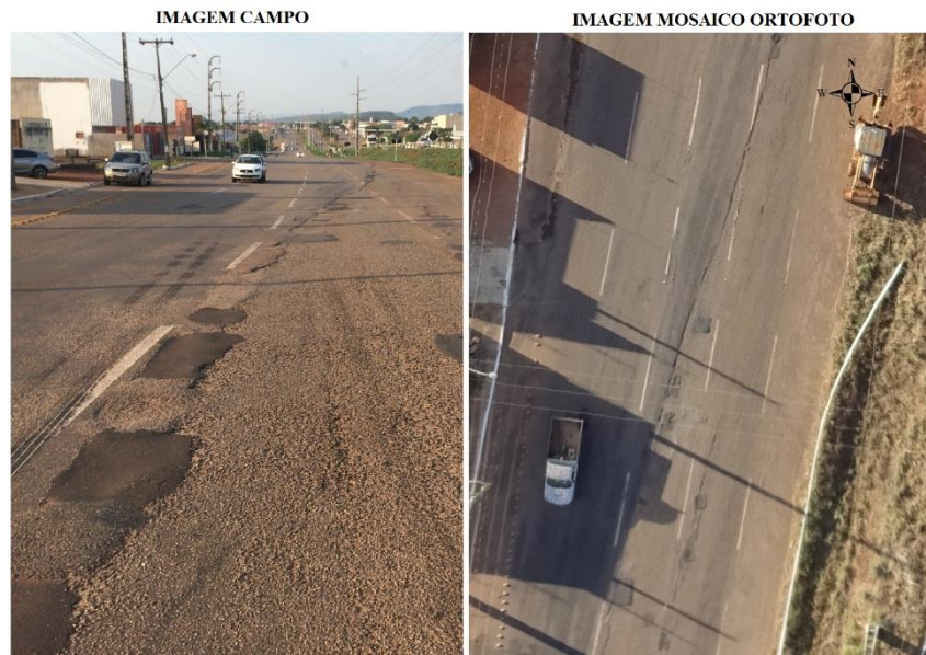
Figura 7. Junta de serviço em trecho ampliado da rodovia.
