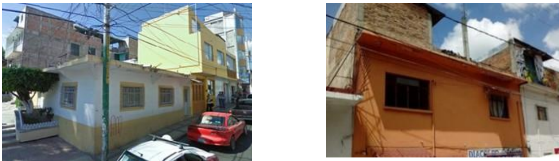
Figura 4. Construções típicas de alvenaria confinada
