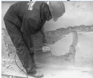
Figura 16a. Processo de desbaste com rebolo
