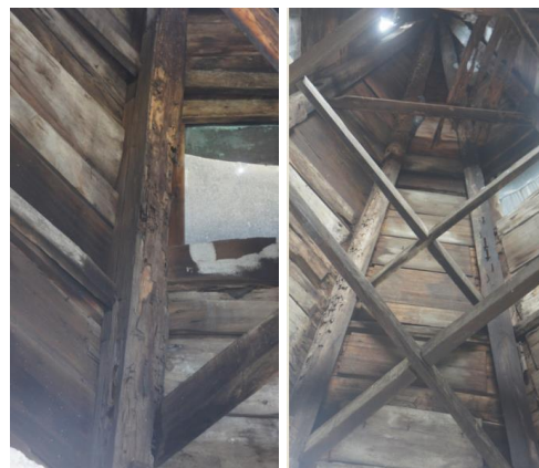
Figura 22. Detalhe da situação da coberta
