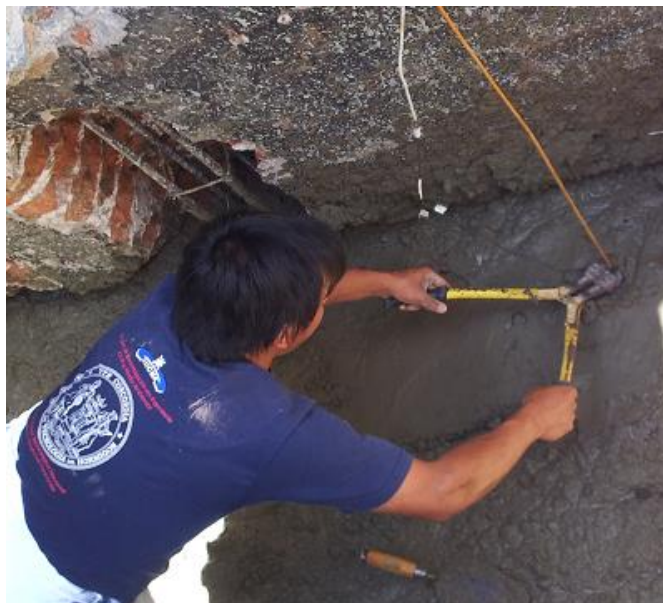
Figura 4. Colocación de sensores
