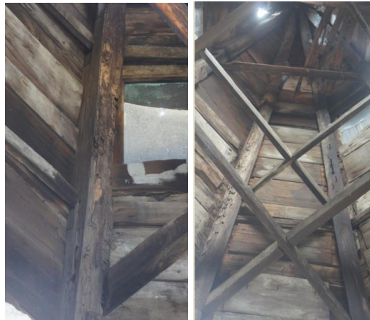
Figura 22. Detalle de la situación de la cubierta
