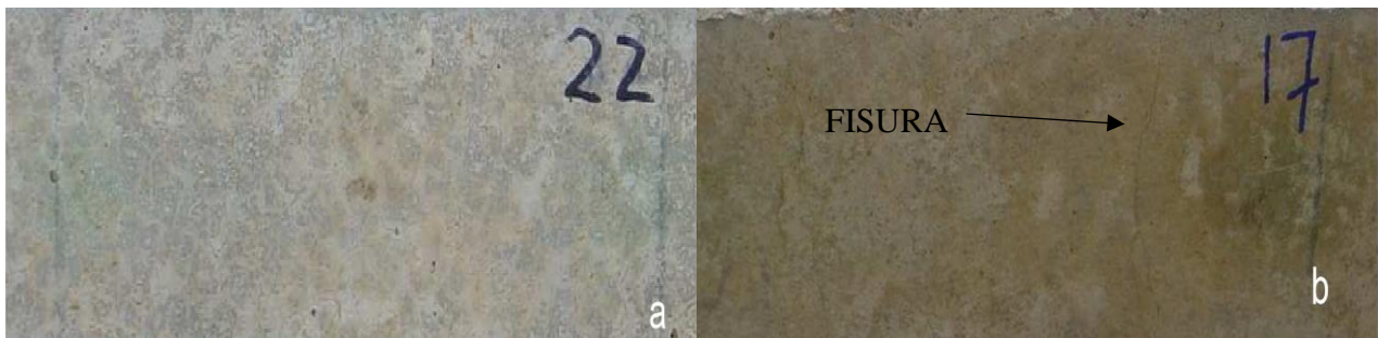
Figura 6. Vigas sin contaminación inicial de cloruros, rociadas 25 cm en la zona central (a) sin precarga aplicada (b) con precarga aplicada
