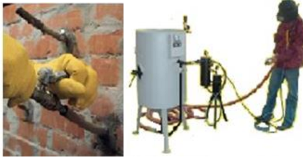
Figura 19. Proceso de inyección: colocación de coples e inyección a través de bomba inyectora de epoxi
