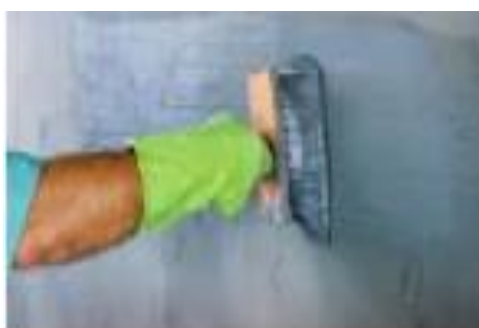
Figura 17b. Aplicación de capa primaria como preparación de superficie
