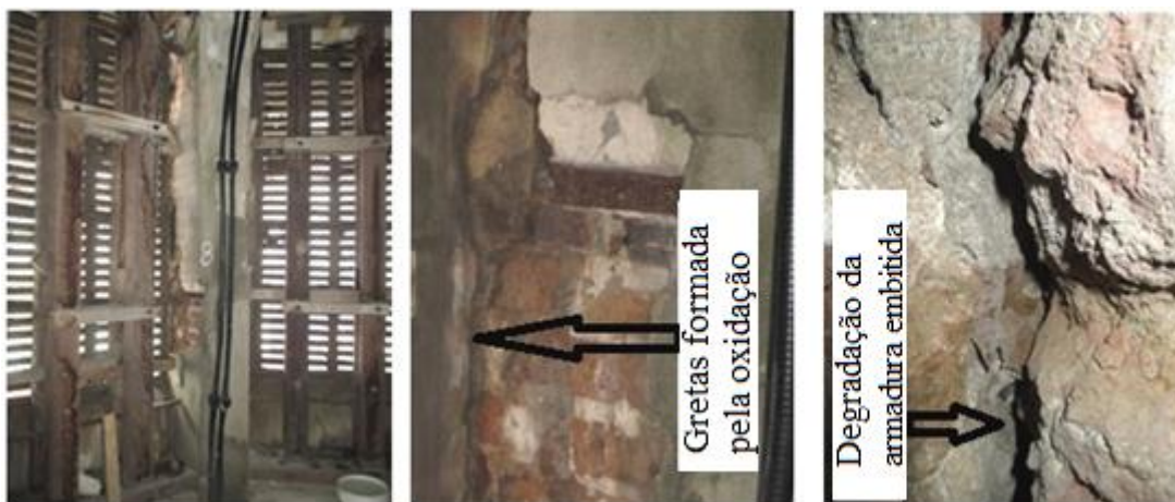
Figuras 4 a 6. Grietas causadas por la oxidación de los estribos de acero de las columnas
