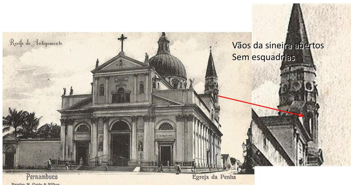
Figura 1. Imagen histórica de la Basílica de la Penha. Detalle de la torre del campanario sin ventilación.
