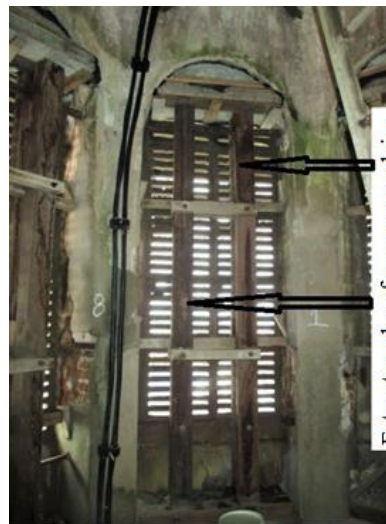
Figura 3. Refuerzo en las columnas del campanario
