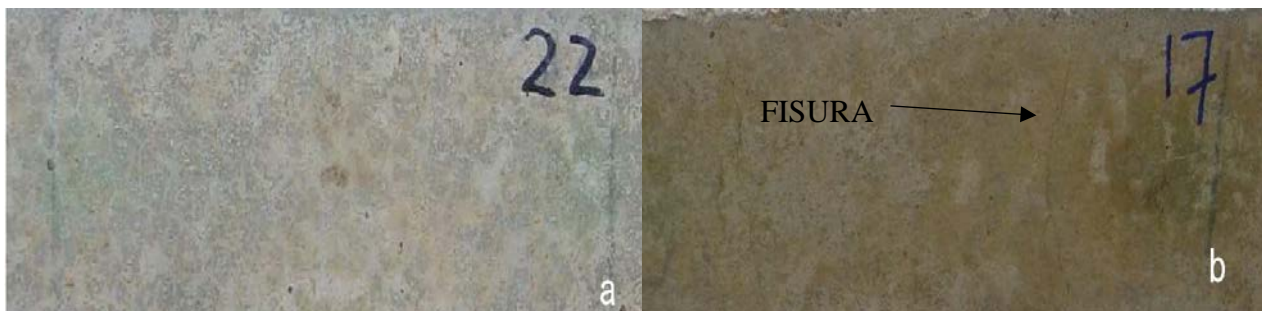
Figura 6. Vigas sem contaminação inicial de cloretos, aspergidas a 25 cm na região central (a) sem pré-carga aplicada (b) com pré-carga aplicada
