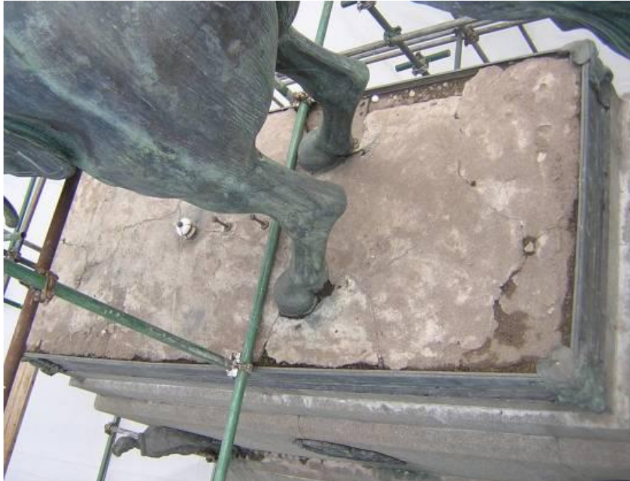
Figura 3. Estado de la cubierta previo a la intervención
