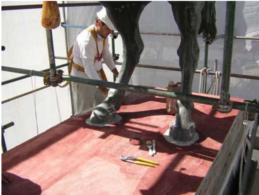
Figura 5. Impermeabilización de cubierta y sellado juntas en apoyo
