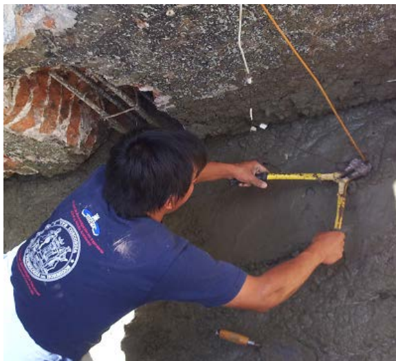
Figura 4. Colocação dos sensores
