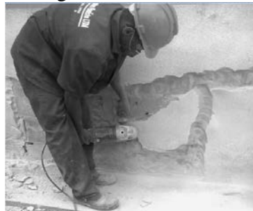
Figura 16a. Proceso de rebajado del revestimiento con piedra de amolar
