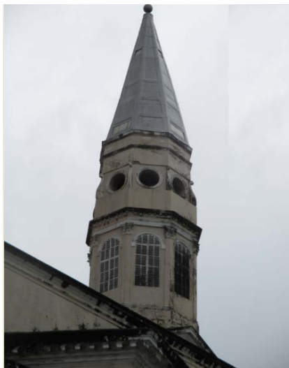
Figura 2. Vista actual de la torre Epístola
