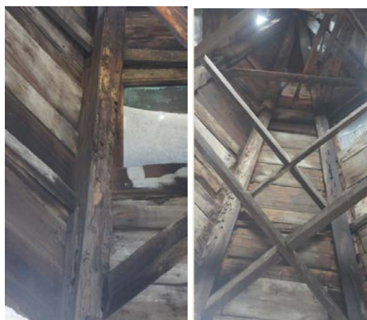
Figura 22. Detalle de la situación de la cubierta
