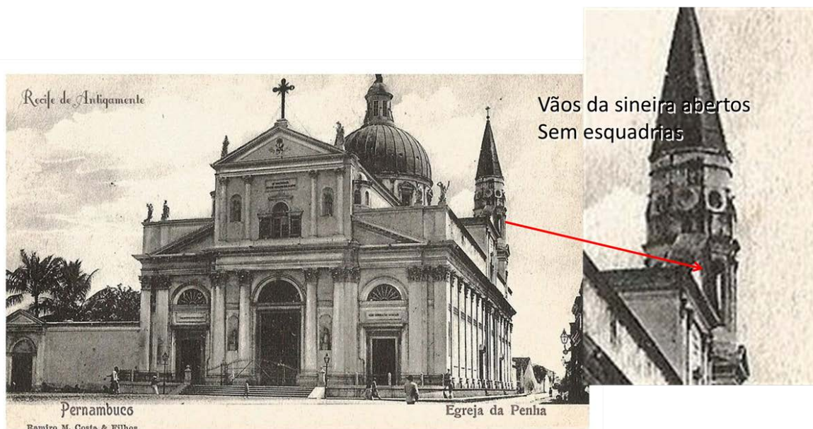
Figura 1. Imagen histórica de la Basílica de la Penha. Detalle de la torre del campanario sin ventilación.
