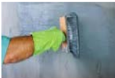
Figura 17b. Aplicación de primer como preparación de superficie
