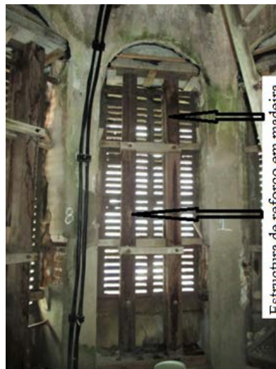
Figura 3. Refuerzo en las columnas del campanário
