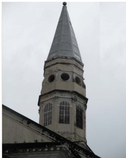
Figura 2. Vista atual da torre Epístola
