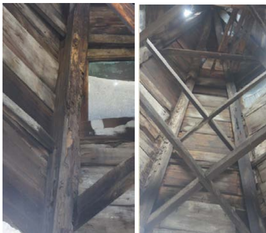
Figura 22. Detalhe da situação da cobertura
