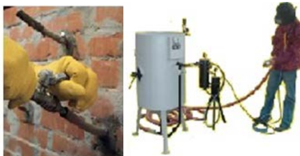
Figura 19. Processo de injeção: colocação de pugadoros e injeção através de bomba injetora de epoxy
