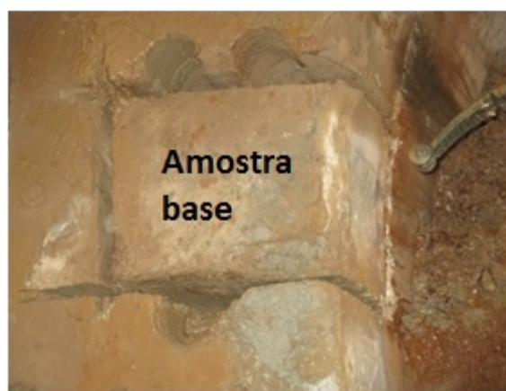
Figura 8. Amostra retirada da alvenaria encaminhada para laboratório.
