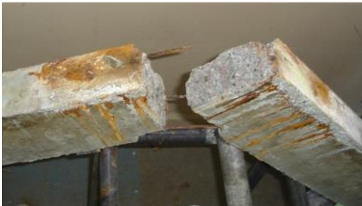
Figura 4. Viga V96 após o colapso.
