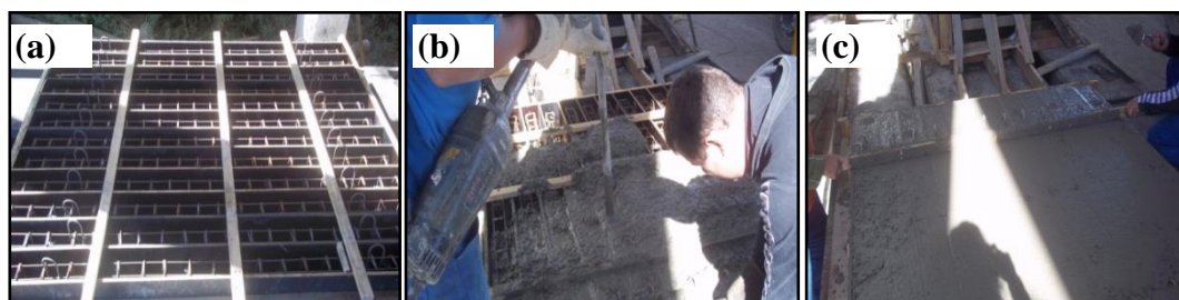
Figura 2. Fabricação das vigas de concreto armado - (a) Formas com armação prontas para concretagem; (b) Concretagem e adensamento com vibradores de imersão; (c) Nivelamento do concreto nas formas.
