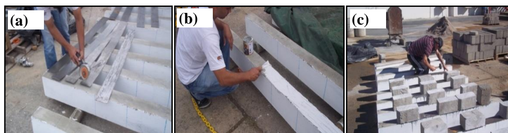
Figura 3. (a) Preparo das chapas; (b) Aplicação do adesivo estrutural epóxi; (c) Fixação e escoramento das chapas.
