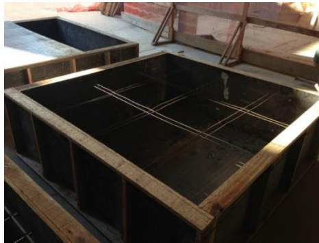
Figura 1. Formas para vaciados das paredes.
