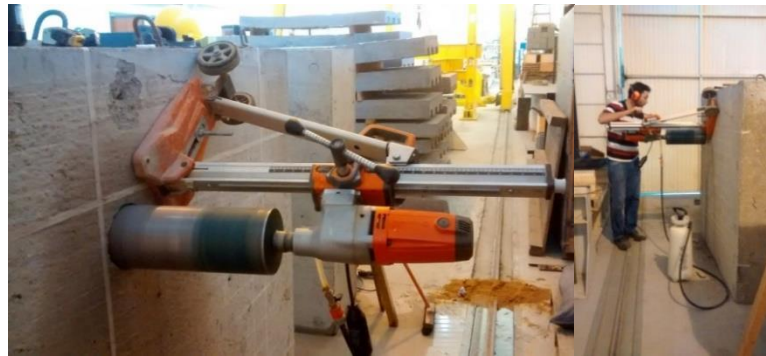
Figura 7. Etapas de avance de las perforaciones
