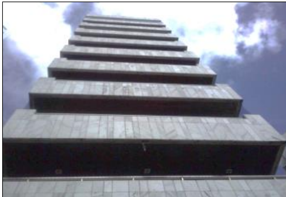
Figura 3. Fachada Este (trecho T1).
