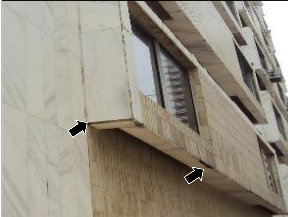
Figura 2. Fachada norte (truchos T5, T6 y T7).
