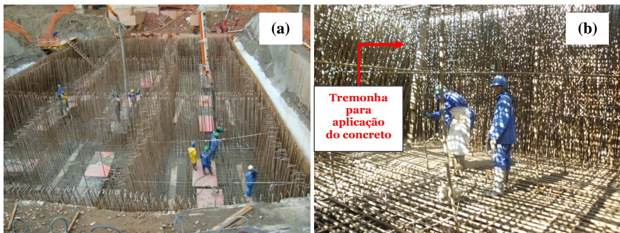
Figura 11. (a) Concretagem da segunda camada sem a armação superior e (b) aplicação do concreto após a montagem de todas as armaduras.
