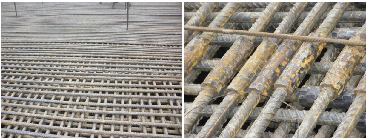
Figura 12. A armação superior consistia de duas camadas duplas de barras de 32mm de diâmetro. O concreto autoadensável foi concebido para atravessar esta malha tanto a superior como a do fundo do bloco que era ainda mais concentrada.
