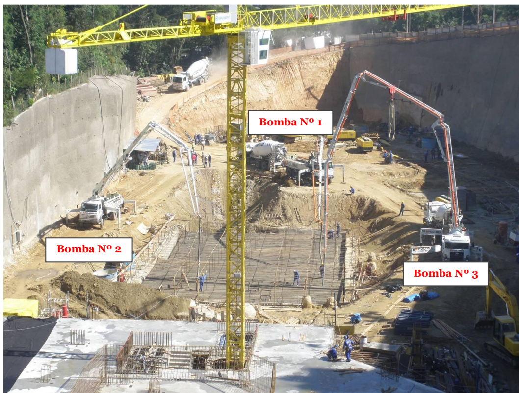
Figura 10. Vista geral – Posicionamento das bombas de concreto.
