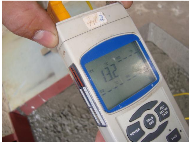
Figura 8. A temperatura do concreto fresco foi controlada para cada caminhão betoneira através da imersão de um termômetro digital (exemplo: 13.2°C).
