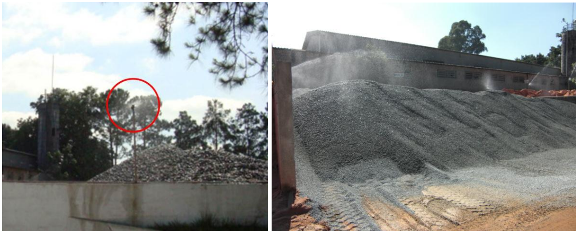
Figura 6. Aspersão de água nos agregados graúdos na central de concreto.
