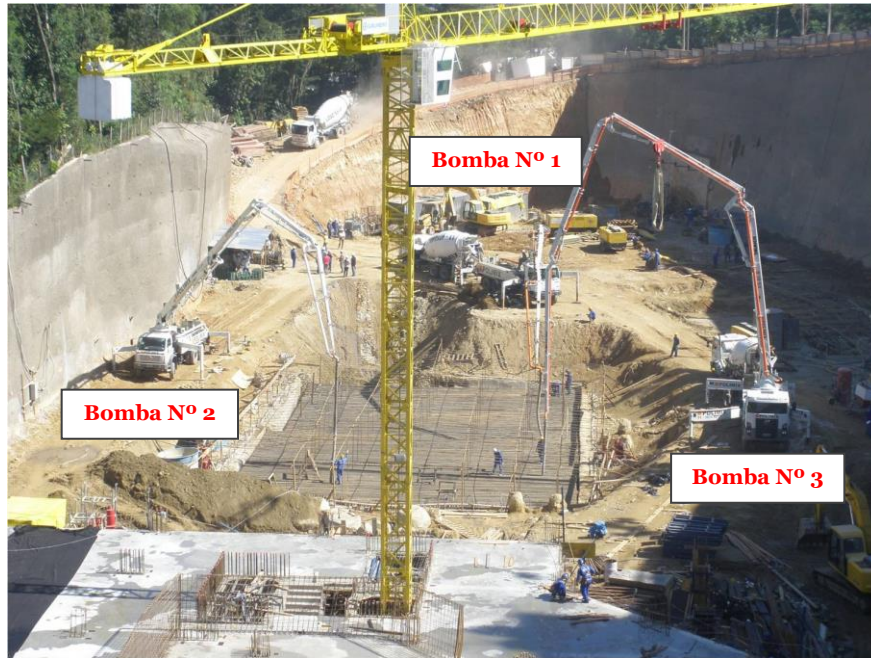
Figura 10. Vista geral – Posicionamento das bombas de concreto.
