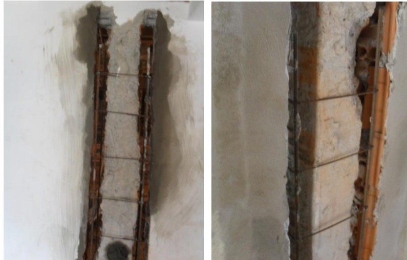
Figura 8. Armaduras longitudinales y estribos del refuerzo de los pilares.
