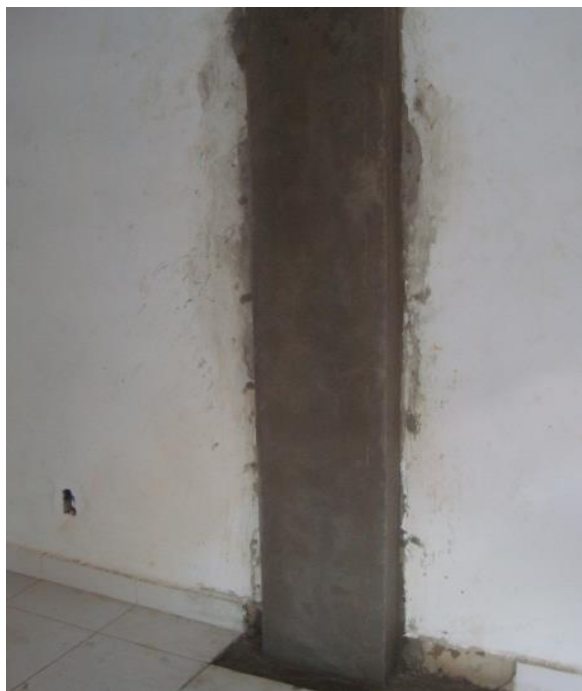
Figura 10. Aspecto final de los pilares reforzados.
