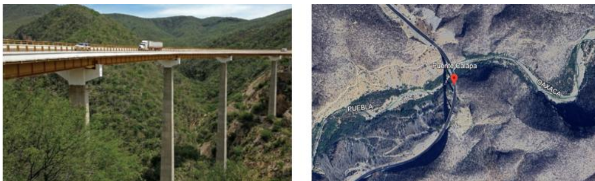
Figura 1. Ponte Calapa, estrutura utilizada como estudo de caso. (a) Vista geral da ponte, extraída de Suarez (2025). (b) Localização na rodovia pedagiada Cuacnopalan–Oaxaca, região central do México. Obtida por meio do Google Earth.
