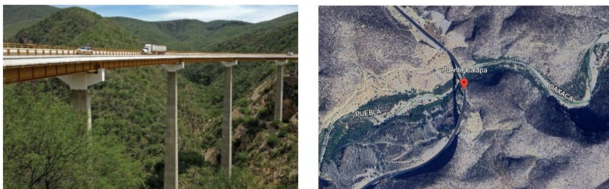
Figura 1. Puente Calapa, estructura de estudio de caso. (a) Vista general del puente, tomada de Suarez, 2025. (b) Ubicación en la carretera de cuota Cuernavaca–Oaxaca, centro de México. Obtenida con Google Earth.
