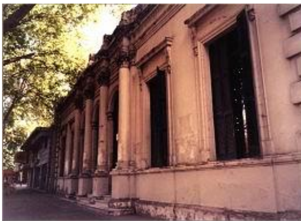
Figura 1. Aspecto de la fachada (año 2000)
