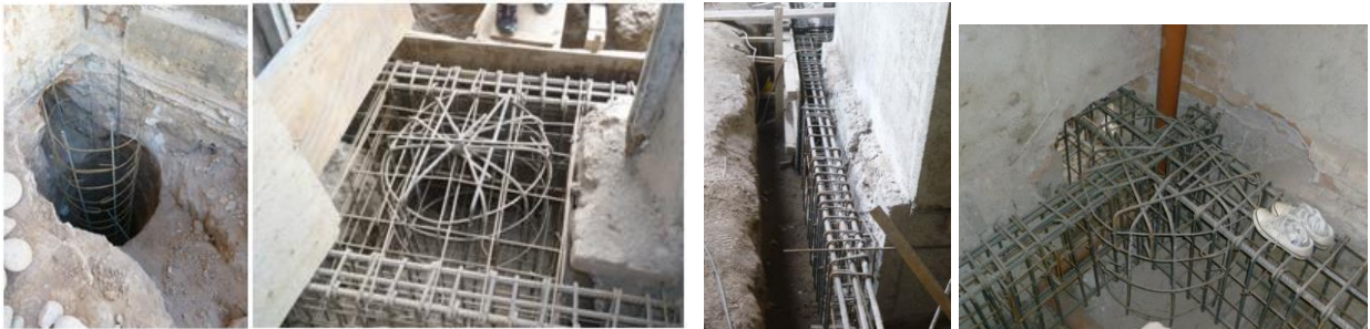
Figura 11. Excavación de pozo, detalle de armado de cabezal, de vigas exteriores al cimiento existente y encuentro de vigas interiores y cabezal de fundación
