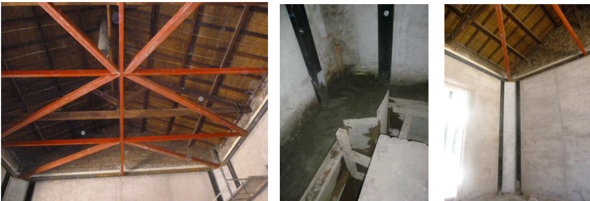
Figura 12. Emparrillado metálico triangulado a nivel de techo, anclaje de columnas en vigas de fundación y columnas y vigas metálicas de encadenado ancladas en la mampostería
