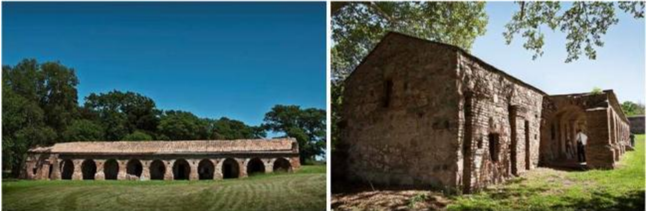
Figura 17. Vistas generales del edificio del Noviciado
