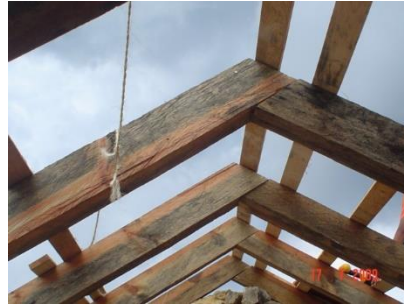
Figura 14. Vigas pares empleadas en la restauración, vista interior
