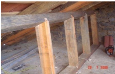
Figura 15. Ensamble de los pies derechos, refuerzo y apoyo.
