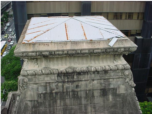
Figura 7. Cobertura metálica das cúpulas. (Fonte: Arquivo da Equipe do Projeto de restauro do MNBA)
