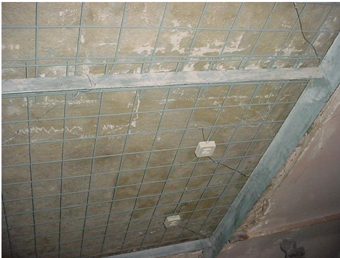
Figura 5. Tela metálica e pastilhas Z. (Fonte: Arquivo da Equipe do Projeto de restauro do MNBA)
