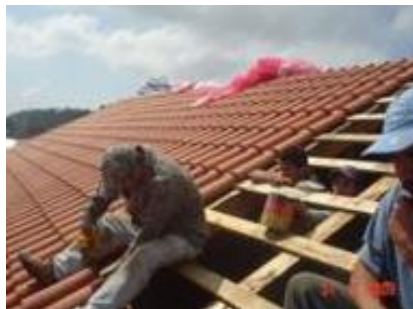
Figura 17. Colocación de la teja de barro rojo extruido sobre fajillas de madera.
