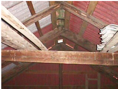
Figura 5. Cubierta actual de la capilla del hospital de Santiago Angahuan.
